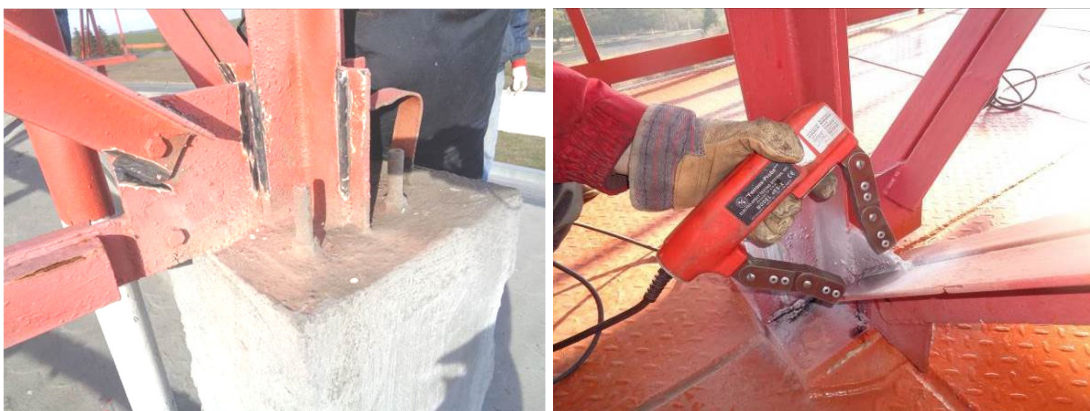
Фотос 3.13 и 3.14 Подготовка (ляво) и „магнитно-прахов“ контрол на ъглови заварки на ДМРЛ Варна
