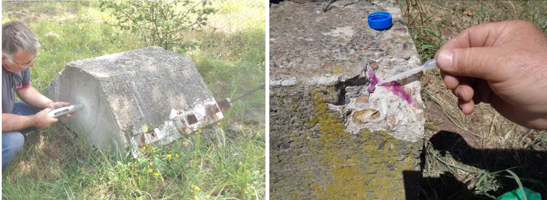
Фотоси 3.3. и 3.4 БК на якостта (ляво) и карбонизацията (дясно) на бетона във фундаменти на NDB
