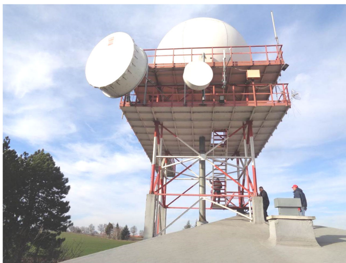
Фотос 2.4. Поглед отблизо към металната носеща конструкция и антенните системи на ДМРЛ „Варна“
