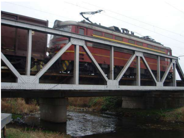
Фиг. 3.21 и 3.22 Моменти от проведените изследвания с АЕ на стоманените ж.п. мостове на km 135 +040 преди г. Стамболийски (ляво) и на km 154 +004 в гр. Пловдив (дясно)
