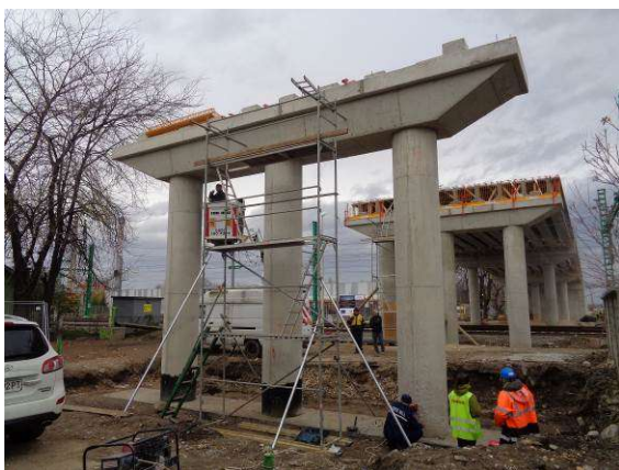
Фиг. 3.33 и 3.34 Моменти от проведените ултразвукови изследвания на еднородността и якостно-деформационните характеристики на бетона в ст.б. колони на Пътен надлез Стамболийски (2017г.)
