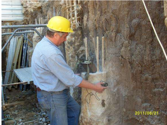
Фиг. 3.19 и 3.20 Моменти от проведените ултразвукови изследвания: на скоростта в бетона (ляво) и на интегритета на пилотите (дясно)
