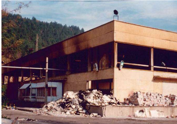
Фиг. 3.8 и 3.9 Общ вид на склада за суровини на фирма Белана след пожара през м. 10.1998г. и план-схема с означение на най-засегнатите от пожара конструктивни елементи
