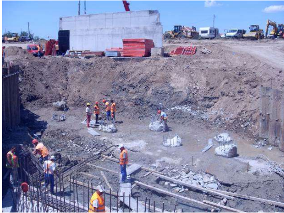
Фиг. 3.15 и 3.16 Общ вид на изпълнените пилоти за стълб Р1 и момент от комбинираното изпитване на интегритета им по двата метода – с „TDR 2“ и „Ultrasonic Cross hole Testing“ (на заден план)
