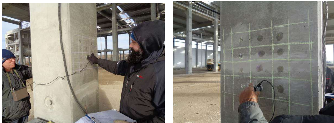
Фиг. 3.39 и 3.40 Моменти от провеждани ултразвукови изследвания за окачествяване на ст.б. колони в новострояща се фабрика за пластмасови съдове в гр. Шумен (2017г.)
