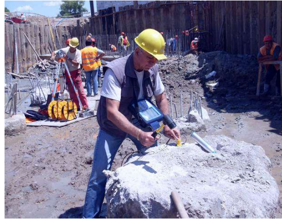
Фиг. 3.15 и 3.16 Общ вид на изпълнените пилоти за стълб Р1 и момент от комбинираното изпитване на интегритета им по двата метода – с „TDR 2“ и „Ultrasonic Cross hole Testing“ (на заден план)
